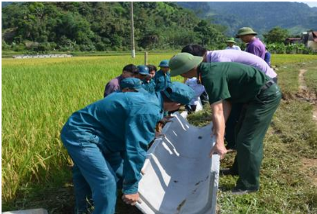
Lực lượng dân quân tự vệ phối hợp với người dân thôn Mùòng, xã Phù Lưu kiên cố hóa kênh mương bằng cầu kiện bê tông đúc sẵn
